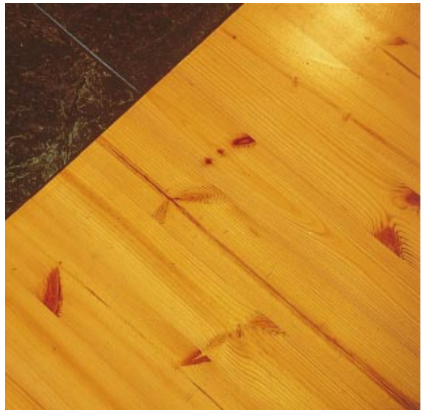
GULVMATERIAL ER VARMEBEHANDLET FURU
